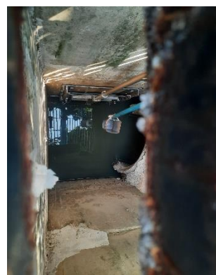
รูปที่ 3.3 บ่อพักน้ำสุดท้ายก่อนระบายลงสู่ระบบระบายน้ำ บริเวณด้านหน้าโครงการ
